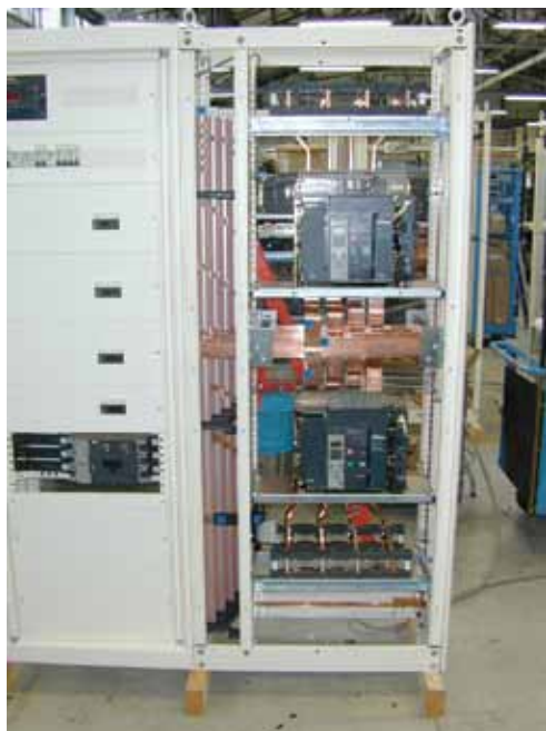
Система ввода резерва, размещённая в двух смежных ячейках
