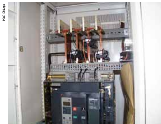
ТТ на вертикальных шинах
